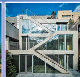
商業店舗ビル
