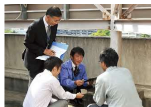
劣化状況の説明
